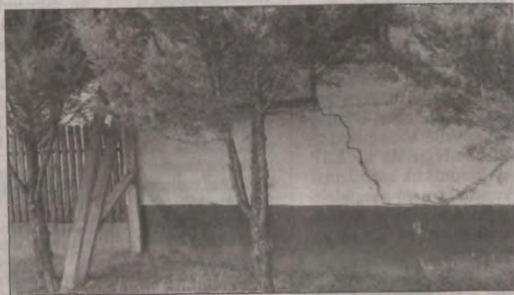
A rendelő hátsó része megsüllyedt, a fal és az alap is megrepedt
