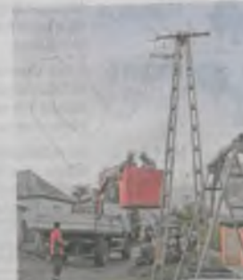
Az E.ON szakembere azonnal megkezdték a helyreállítást
