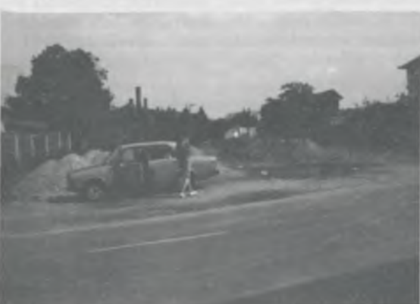
A község eddigi életében a legnagyobb beruházás a vezetékes gázellátás kiépítése volt. Képeinken a vezetékek számára kiásított árok látható
